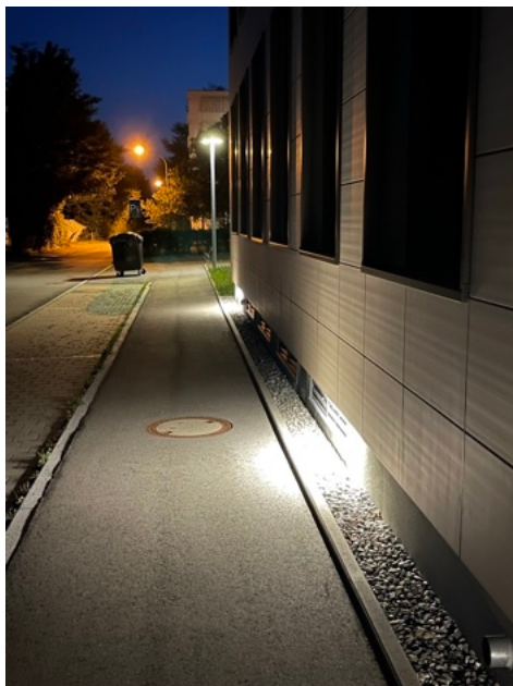
Bild 15 Unterschiedliche Lichtwirkungen: Im Hintergrund Gelblichtleuchte an einem Peitschenmast. Im Prinzip ist Gelblicht die etwas bessere Variante, wenn es um eine insektenschonende Beleuchtung geht. Im gezeigten Fall wird aber durch die Anbringungshöhe deutlich, dass Licht in größerem Ausmaß in die Bäume fällt, wo es nicht benötigt wird und auch nicht hingehört. Der Nachteil der eingesetzten Rundlichtleuchten an ca. 4 m hohen Masten wurde oben aufgezeigt. Bodennahe Beleuchtungen im Vordergrund.
