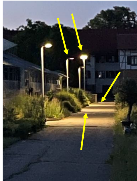
Bild 14 Am Boden nahezu gleiche Beleuchtung in der Fernwirkung massive Unterschiede durch unterschiedliche Leuchten Rechts Lichtverschmutzung deutlich höher
