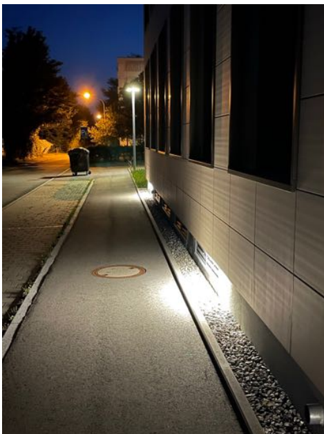
Bild 15 Unterschiedliche Lichtwirkungen: Im Hintergrund Gelblichtleuchte an einem Peitschenmast. Im Prinzip ist Gelblicht die etwas bessere Variante, wenn es um eine insektenschonende Beleuchtung geht. Im gezeigten Fall wird aber durch die Anbringungshöhe deutlich, dass Licht in größerem Ausmaß in die Bäume fällt, wo es nicht benötigt wird und auch nicht hingehört. Der Nachteil der eingesetzten Rundlichtleuchten an ca. 4 m hohen Masten wurde oben aufgezeigt.
