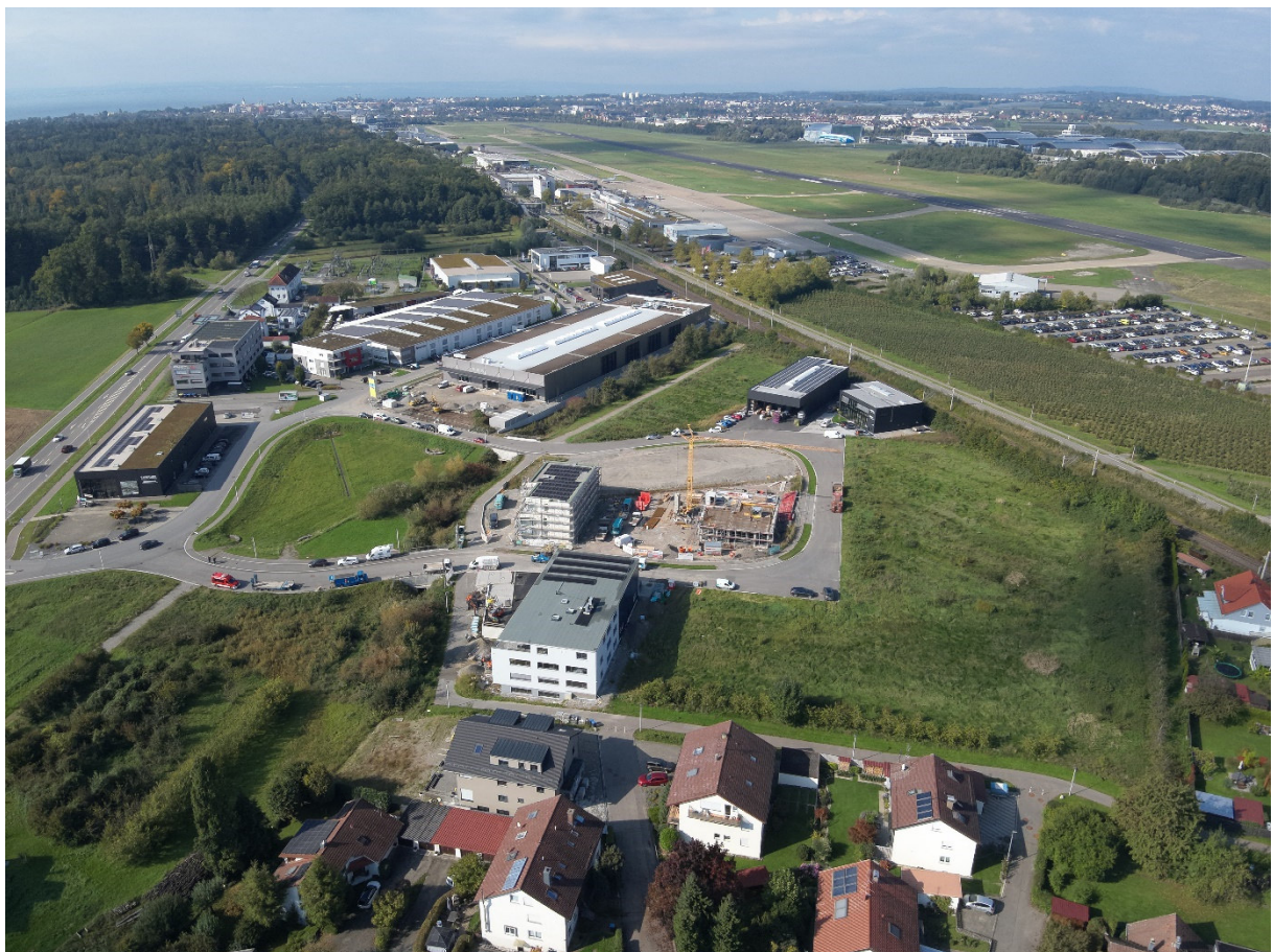
Abbildung 1: Luftbild Gewerbegebiet Meckenbeuren-Flughafen
