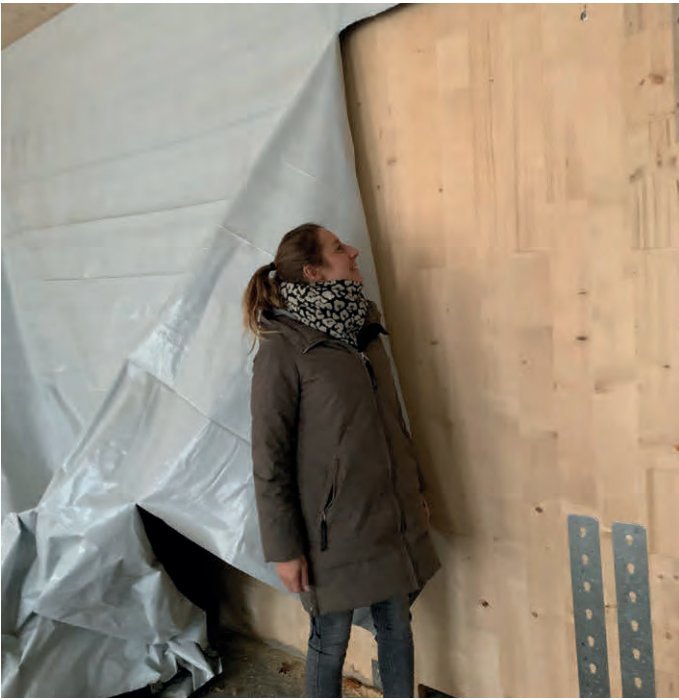
Das Dach – aktuell mit einer Dampfsperre versehen – erhält noch eine Wärmedämmung sowie darüber weitere Abdichtungen inklusive durchwurzelungsfester Folie. Denn es wird begrünt.
